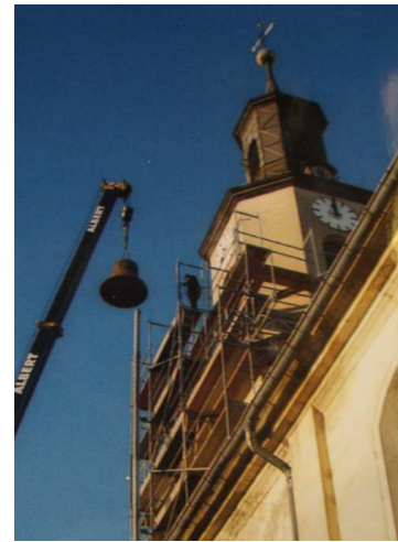
2001-2003 wurde der Turm denkmalgerecht instand gesetzt. Die drei Glocken wurden in einem neuen Glockenstuhl aufgehängt.
